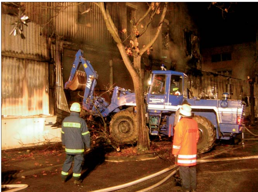
Wandöffnung: Für den umfassenden Außenangriff wurde die Außenhaut an mehreren Stellen geöffnet. Später in der Nacht kam das THW mit schwerem technischem Gerät zum Einsatz.
